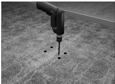
Просверлите 4 отверстия \varnothing 13 в дорожном покрытии.
